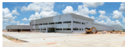
建屋の建設が進む現地
