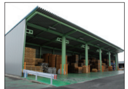
スキッド専用保管倉庫
