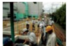
環境監査(小山工場)
