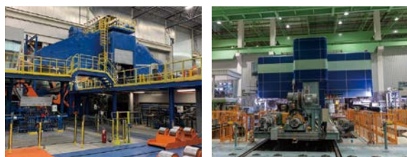
TAA (左)とUATH (右)の新設した冷間圧延設備
