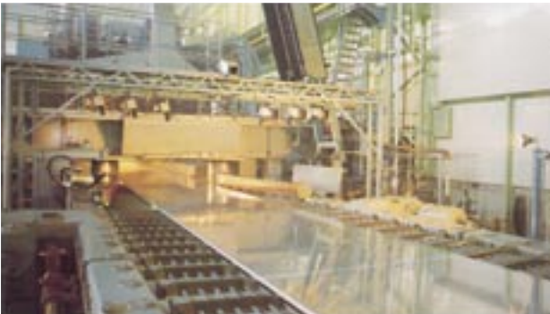
図4 熱間粗圧延機 Fig.4 Hot roughing mill.
