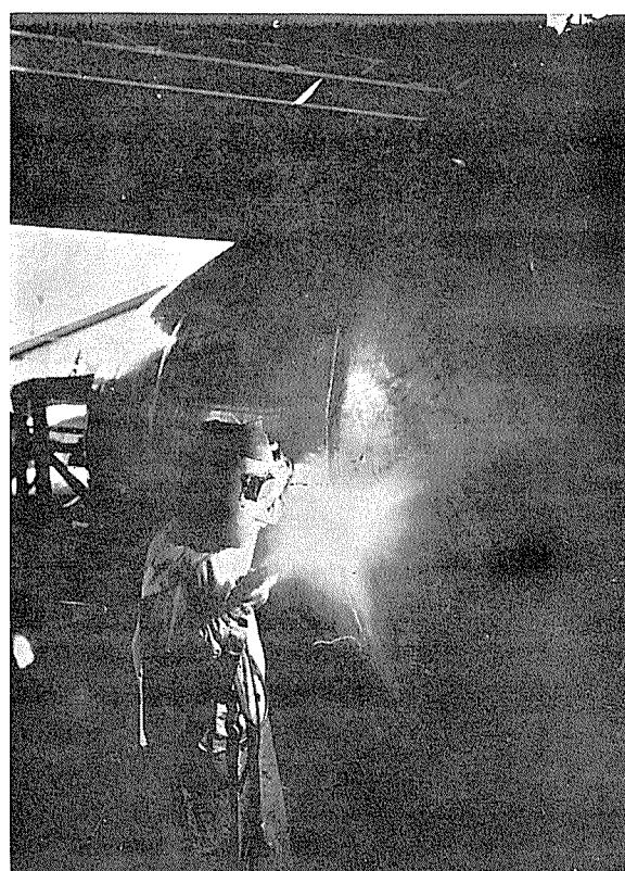
写真5 立向姿勢の溶接—MIG溶接—
