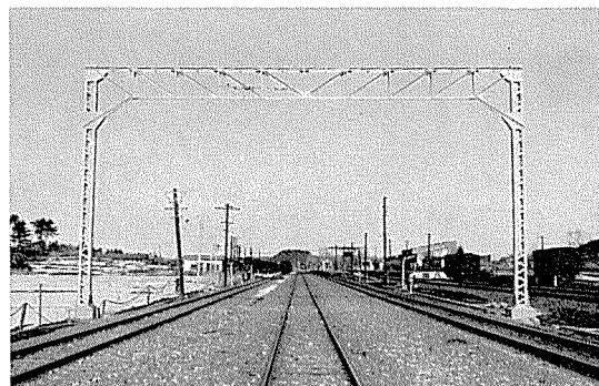
写真1 アルミニウム合金製電車線路支持物
