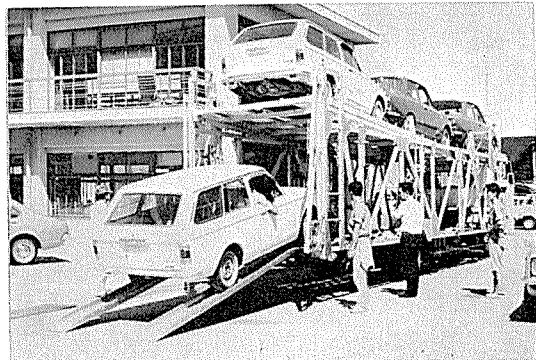
図12 積降し用道板を用いる試作車両積載車への車両積込み作業
