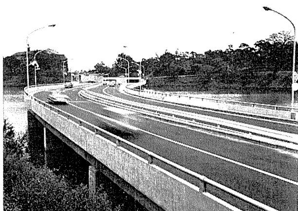
写真3 剛性防護柵上に設置されたパイプ高欄
