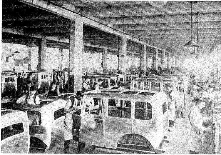
図4 1920~25年頃のアルミニウム製車体の製造状況
