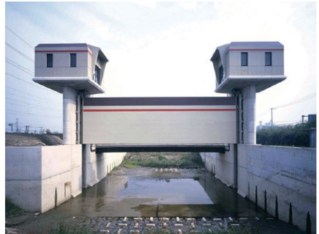
Fig. 4 The Oyumigawa floodgate.
