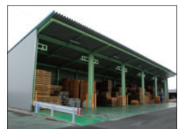
スキッド専用保管倉庫
