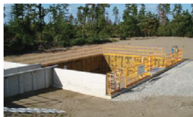
雨水排水緊急避難槽
