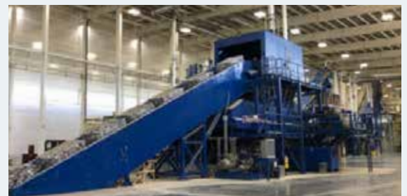
2018年に稼働したリサイクル炉
